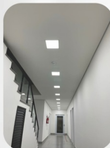
Forro em Drywall
